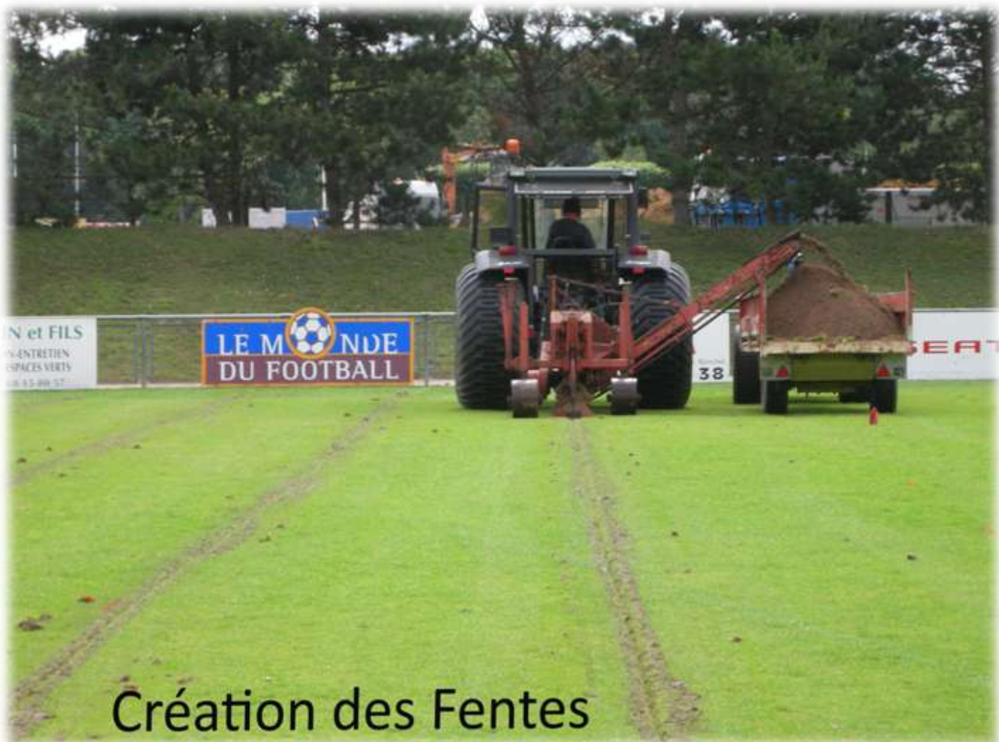
Remplissage des fentes
