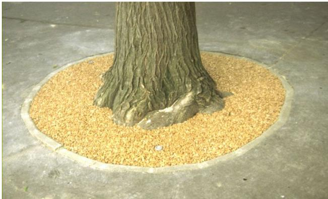
La protection physique des cuvettes des arbres est excellente en raison de la dureté du matériau choisi ( graviers divers, porphyre, marbres.....) et de la résistance mécanique de la résine.
